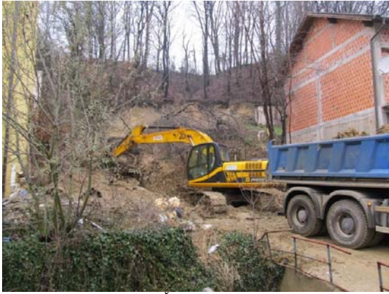
Slika 7 Klizište u ulici Črnomerec. Izvođenje radova hitne sanacije
