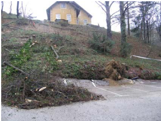
Slika 2 Klizište u ulici Dubravkin put
