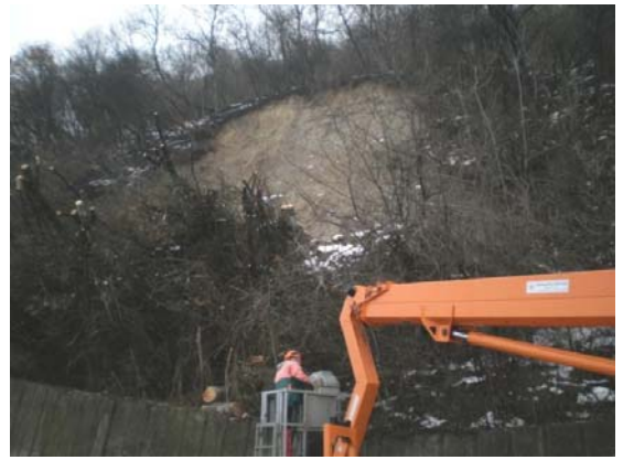
Slika 4 Klizište Aleja Bologne. Izvođenje radova hitne sanacije
