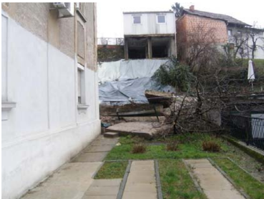
Slika 8 Destabilizacija tla i srušeni zid u ulici Sv. Duh
